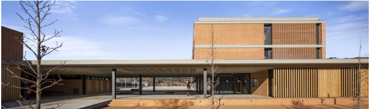
IES Les Aimerigues en Terrassa Arq. Barceló Balanzó Arquitectes Foto: Simón García
